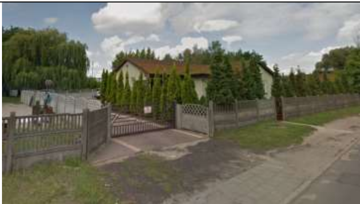
Fot. 3 Widok na budynek mieszkalny jednorodzinny, znajdujący się po zachodniej stronie ulicy Towarowej.
