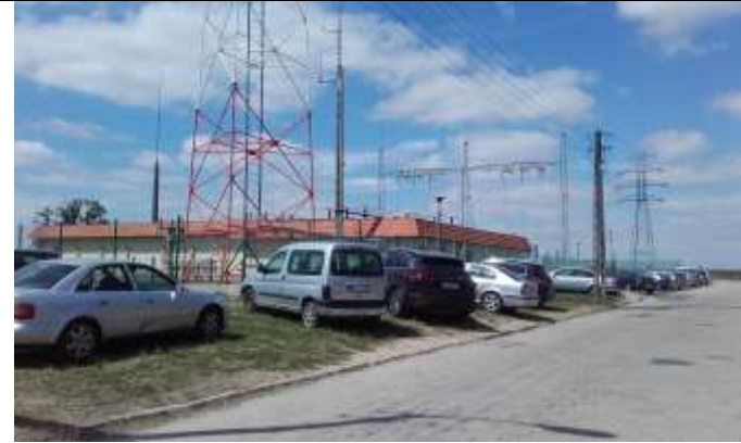
Fot. 2 Widok z ulicy Nagórnej w kierunku północnym, na stację transformatorową.
