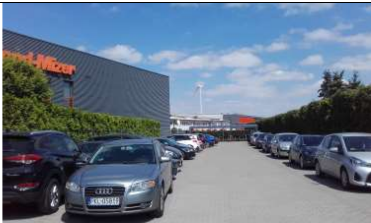
Fot. 5 Widok na budynek biurowy przy zakładzie produkcyjnym.
