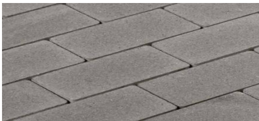
Fot5. Nawierzchnia z kostki betonowej.
