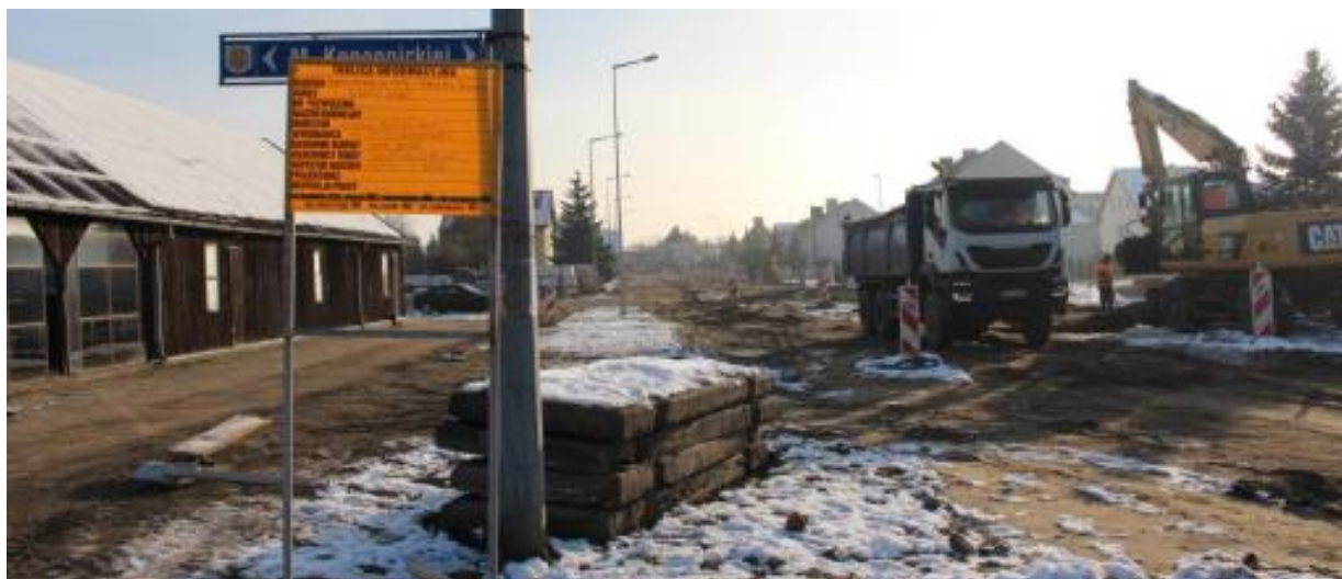
Rysunek 11 Ulica Staffa w Kole w trakcie realizacji inwestycji.
