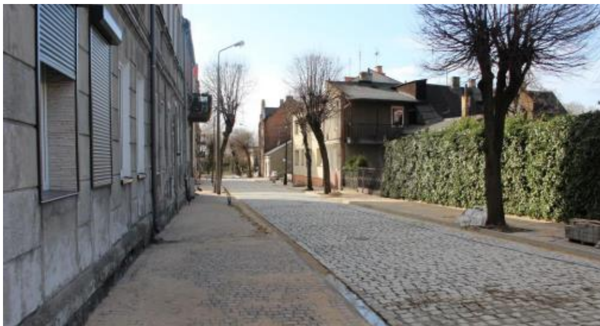
Rysunek 10 Ulica Grodzka w Kole po przebudowie.
