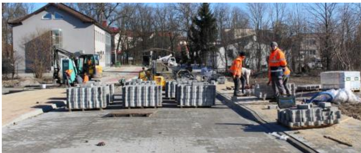
Rysunek 12 Ulica Szymborskiej w Kole w trakcie realizacji inwestycji.
