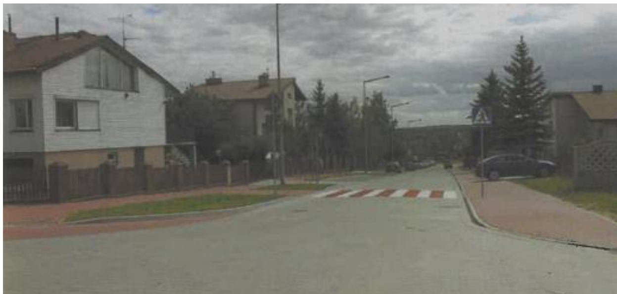
Rysunek 13 Ulica Cegielniana w Kole po przebudowie.
