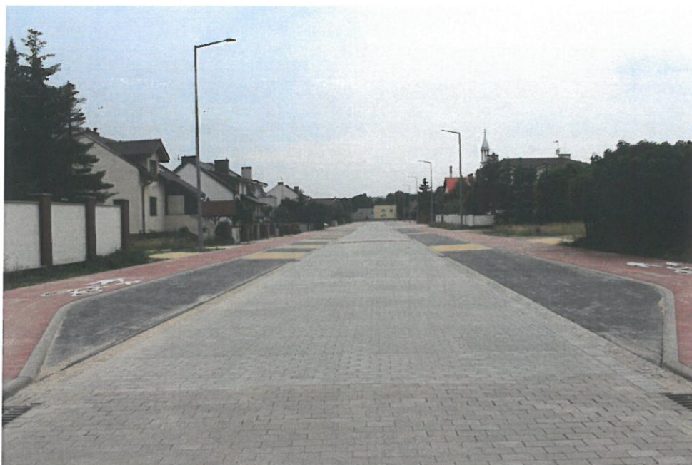
Ukończona budowa ul. Leopolda Staffa
