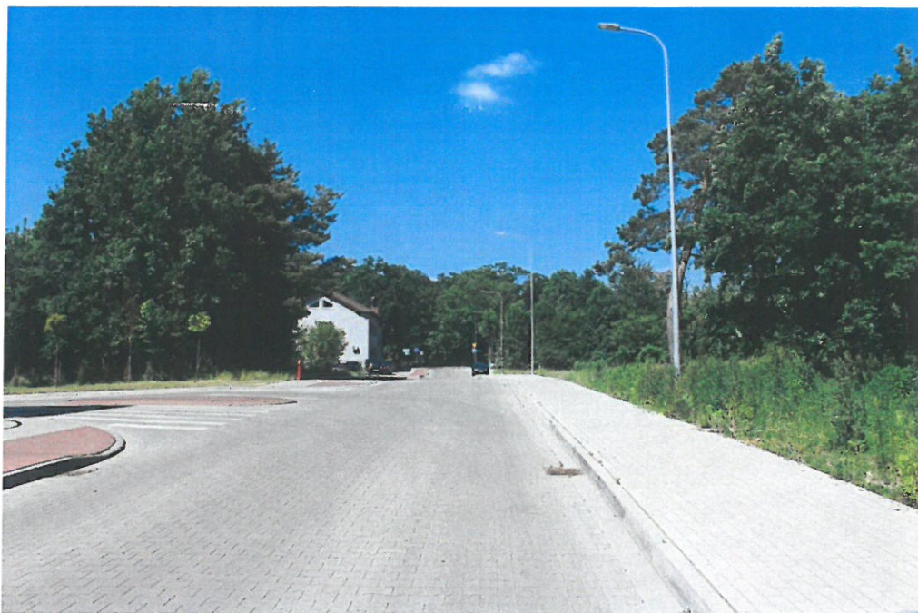
Ukończona budowa ul. Wisławy Szymborskiej
