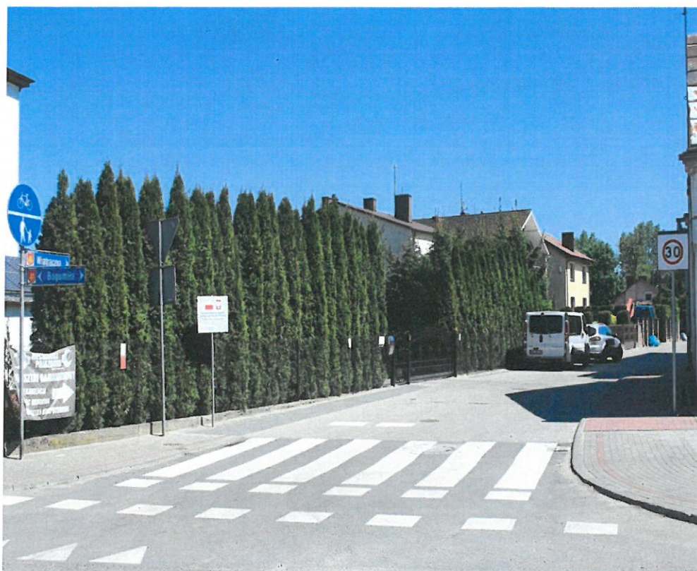
Ukończona budowa ul. Wiatracznej
