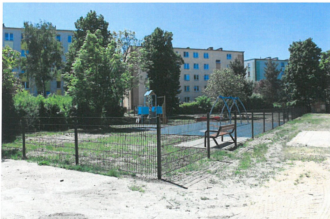
Ukończona budowa placu zabaw w rejonie ulic Wojciechowskiego - Broniewskiego
