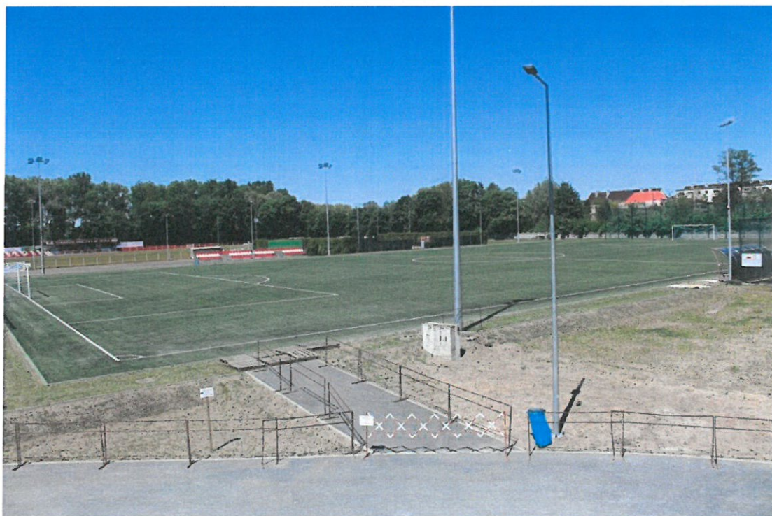
Ukończona przebudowa boiska piłkarskiego na stadionie przy ul. Sportowej 12 w Kole
