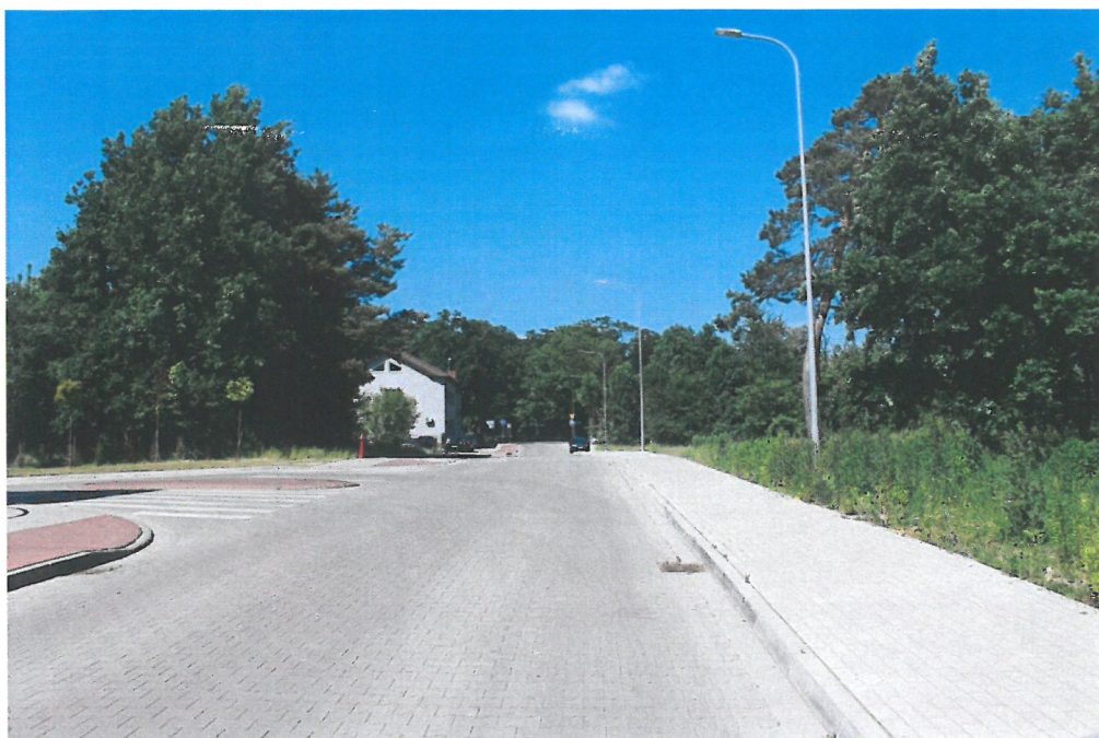
Ukończona budowa ul. Wisławy Szymborskiej
