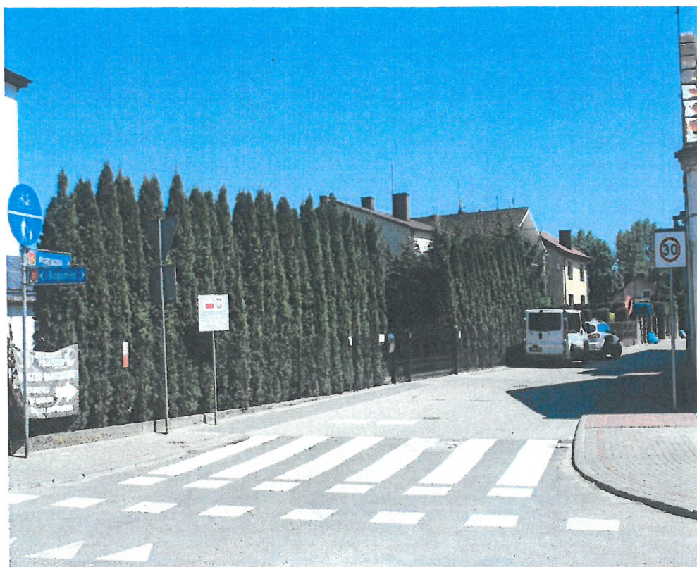
Ukończona budowa ul. Wiatracznej
