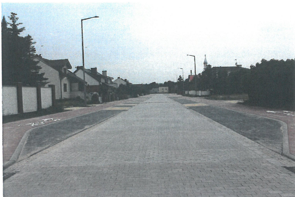
Ukończona budowa ul. Leopolda Staffa
