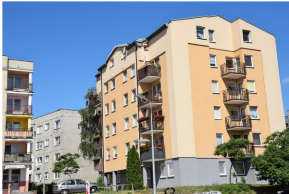
Fot. 5. Osiedle zabudowy wielorodzinnej przy ul. Ks. Opalki
