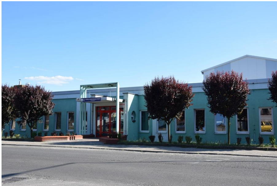
Fot. 24. Stacja uzdatniania wody
