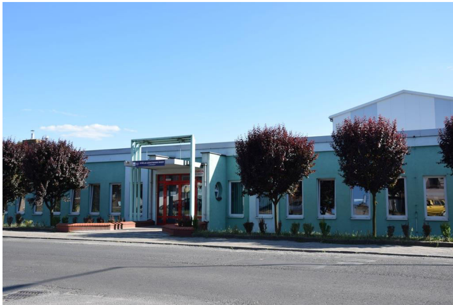
Fot. 24. Stacja uzdatniania wody
