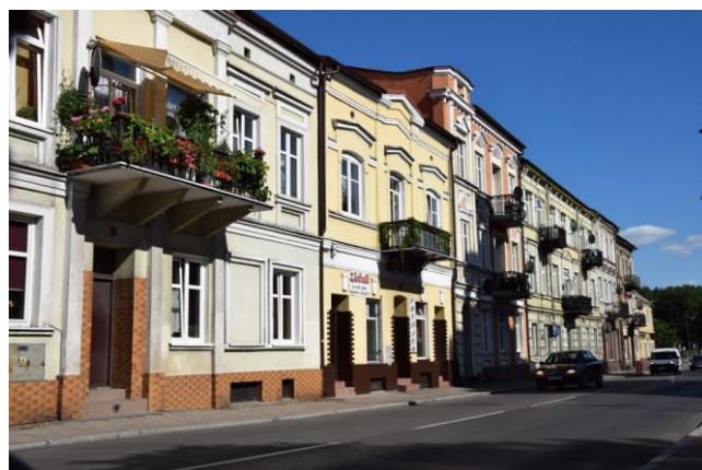
Fot. 2. Historyczna zabudowa przy ul. A. Mickiewicza
