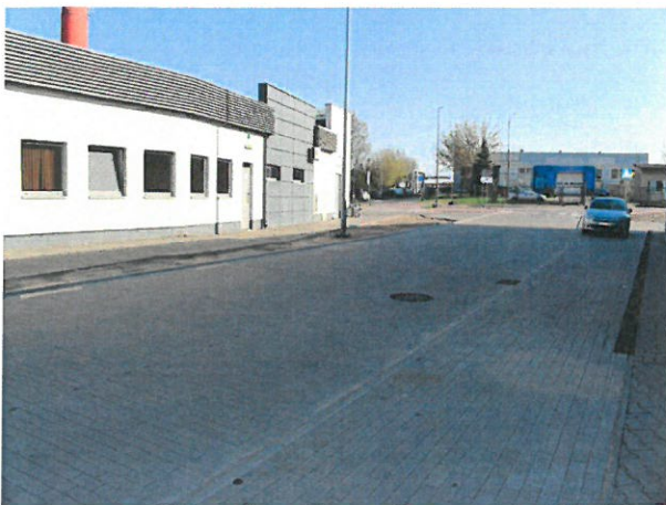
Droga wewnętrzna wraz z łącznikiem w ul. Przesmyk
