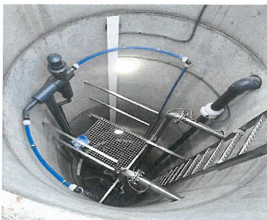
Przepompownia ścieków na nowo wybudowanym odcinku kanalizacji Toruńska - Zakładowa
