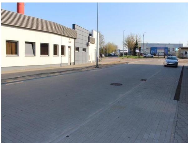
Droga wewnętrzna wraz z łącznikiem w ul. Przesmyk
