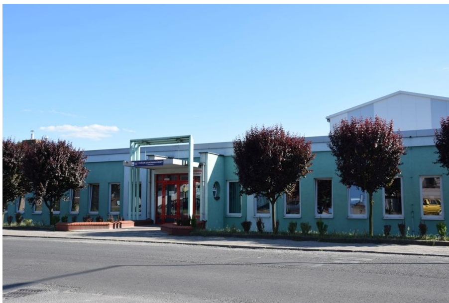
Fot. 24. Stacja uzdatniania wody
