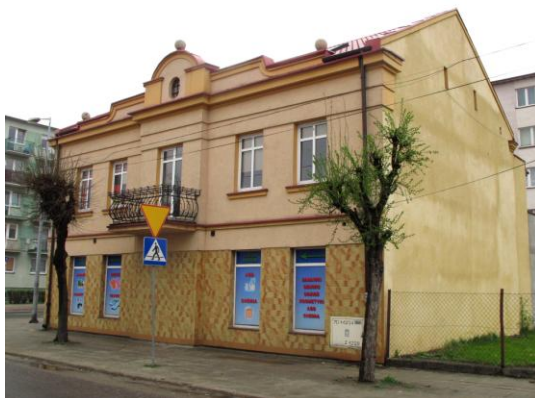
Fot. 17. Dom mieszkalny przy ul. 20 Stycznia 12
