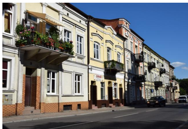
Fot. 2. Historyczna zabudowa przy ul. A. Mickiewicza
