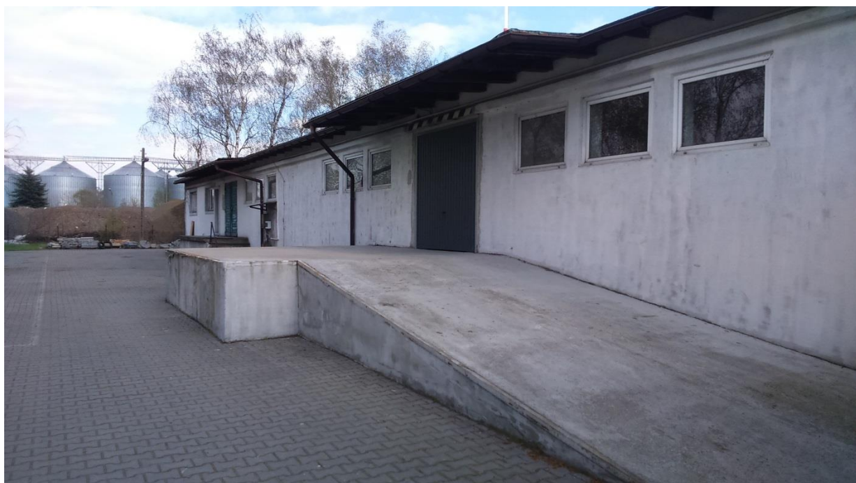
Rysunek 18 Jedna z hal na obszarze przemysłowym przed przebudową (źródło: Remedis SA)
