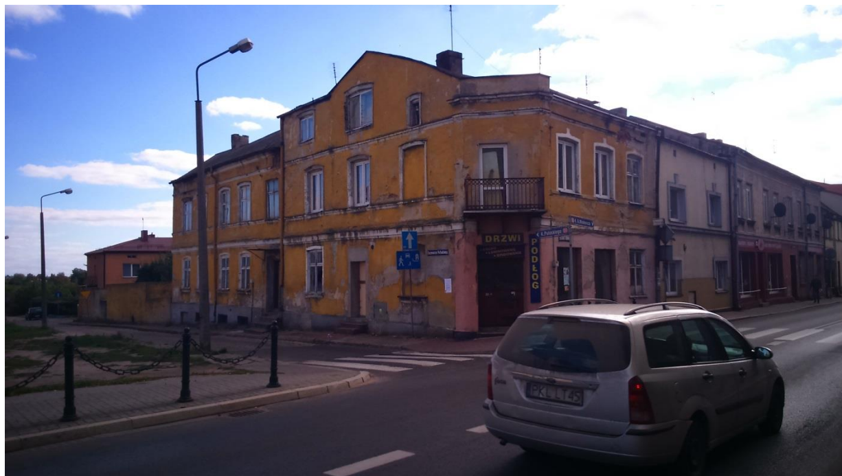
Rysunek 10 Zniszczony budynek na narożniku ulic Mickiewicza i Puławskiego (źródło: Remedis SA)
