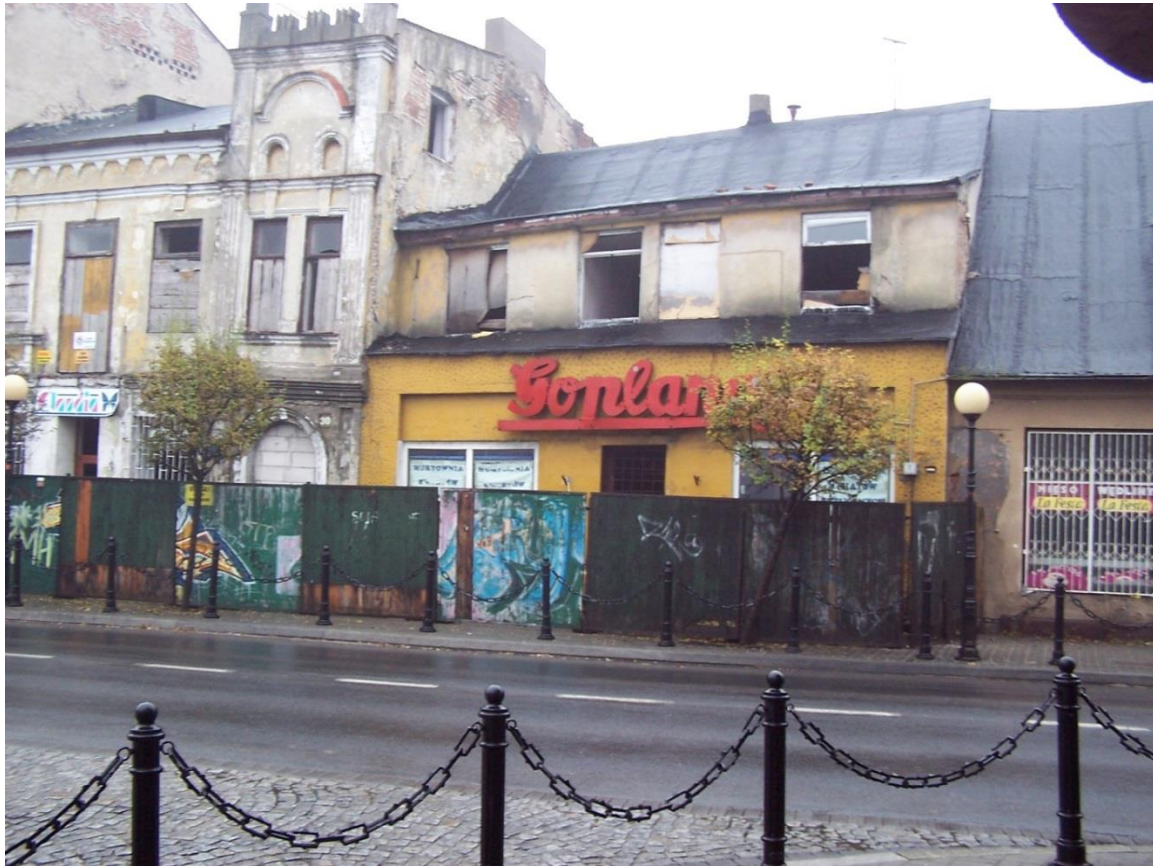
Rysunek 8 ul. Stary Rynek 30 i 31, stan przed rozebraniem budynków (źródło: Urząd Miejski w Kole)
