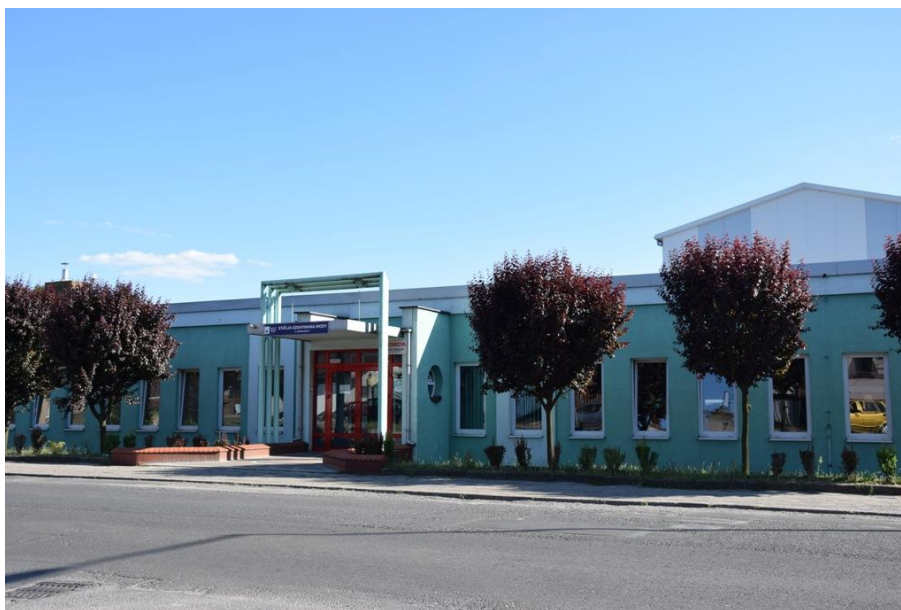
Fot. 24. Stacja uzdatniania wody
