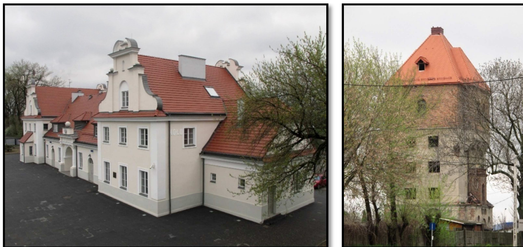
ul. Kolejowa, dworzec i wieża ciśniń
